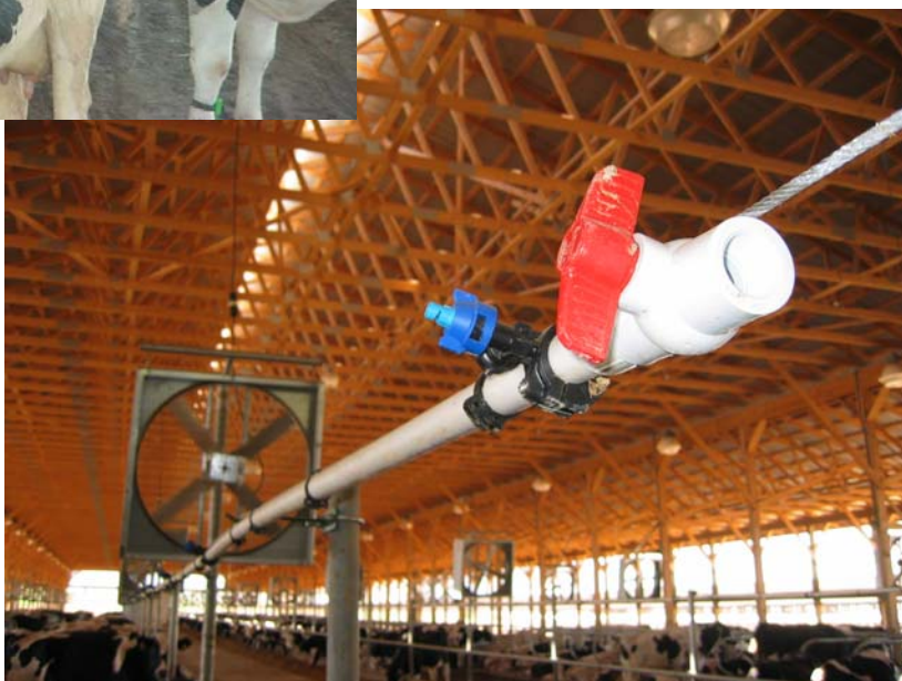
PVC 1 дюйм: TeeJet на хомуте с обратным клапаном, крепление к натянутому тросу ¼ дюйма.
